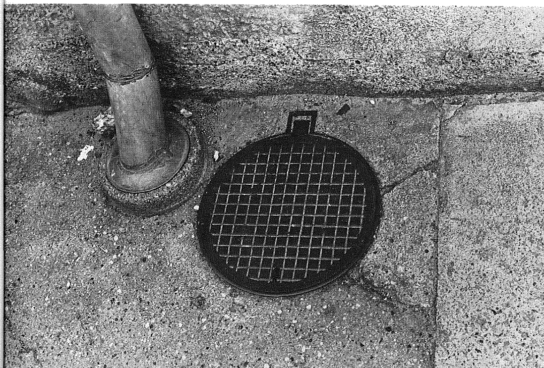
Figur 6. Til mange ting kan støbejern anvendes uden korrosionsbeskyttelse, selv om det korroderer lige så hurtigt som stål.
