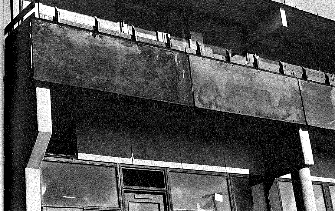
Figur 30. Nyopsatte facadeplader af korrosionstrægt stål (øverste foto) er stærkt blakkede, men efter 3 år er pladerne næsten ensfarvede (nederste foto).
